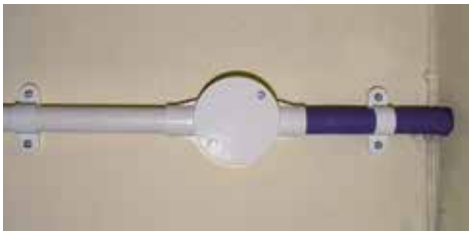
Firoblok® conduit sleeve ( BESA box )
